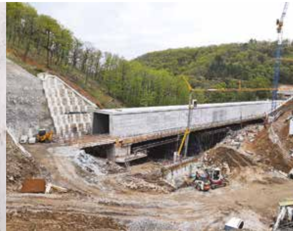
Viadukt Glinščica 2. tir – 2TDK
